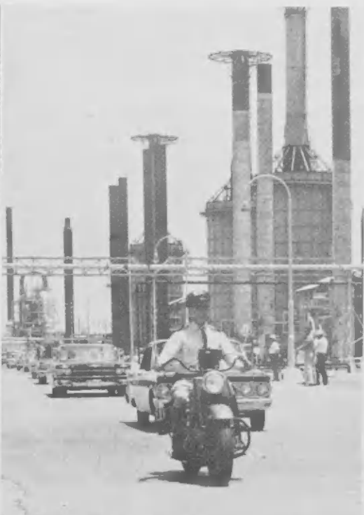
DEN EMPLOYEE Medical Center e prinsesnan ta worde muntrá e facilidanan door di Dr. J. J. Waasdorp. Nan a pasa den auto dilanti Acid and Edeleanu Plants y over di camina grandi di refinaria dilanti Combination Units, banda drechi.
